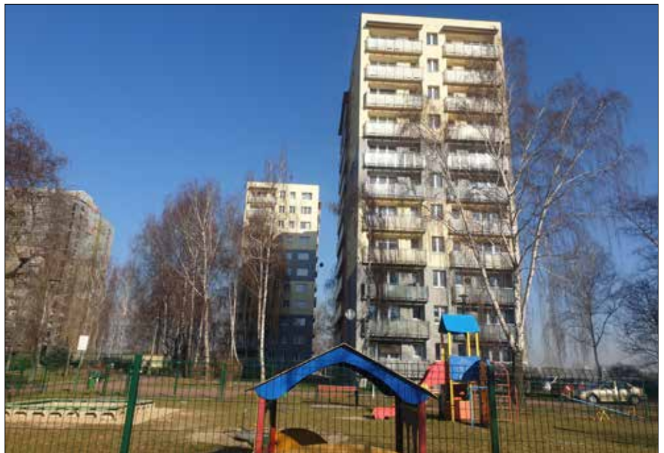
Na zdjęciu: ocieplone budynki przy ul. Morawa 119e i Morawa 119f
