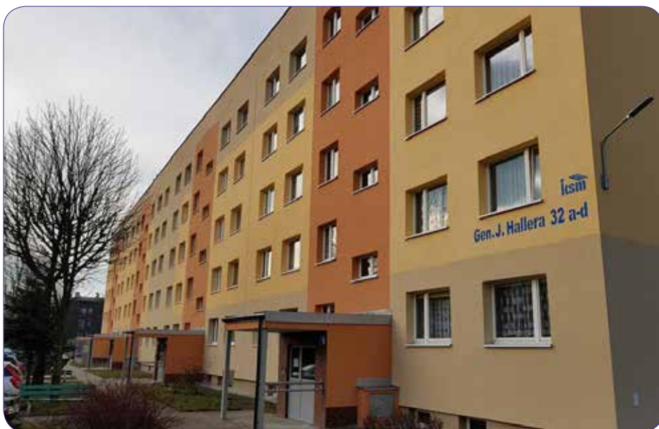
Budynek przy ul. Hallera 32 a-d
