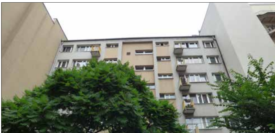
Śródmieście – budynek przy ulicy Kobylińskiego 2a
