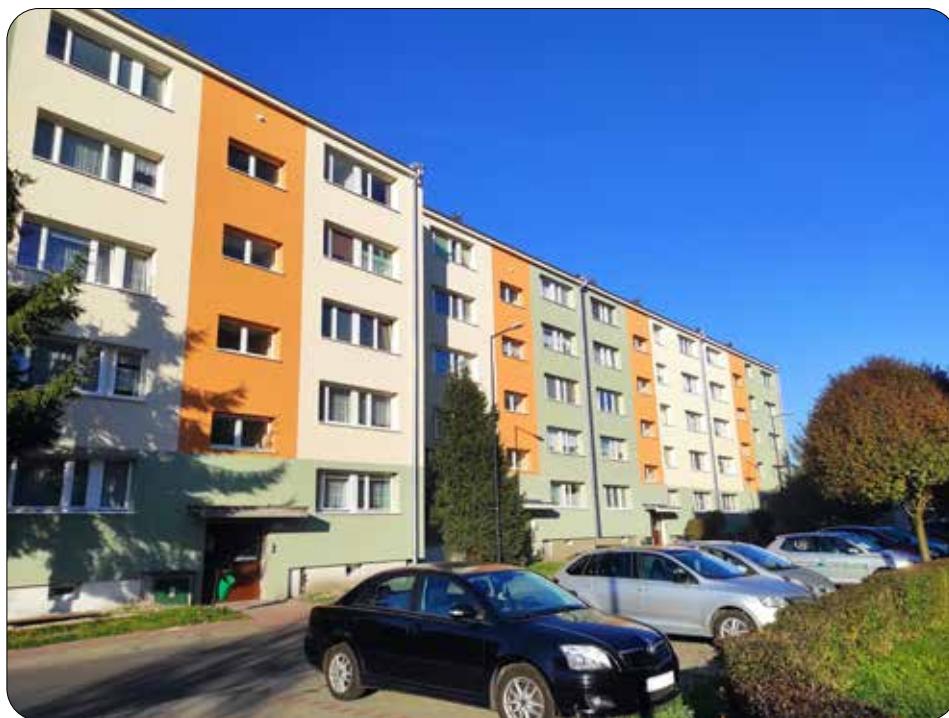
Budynek przy ul. Bohdanowicza 2
