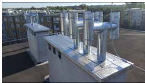
Montaż nasad kominowych
