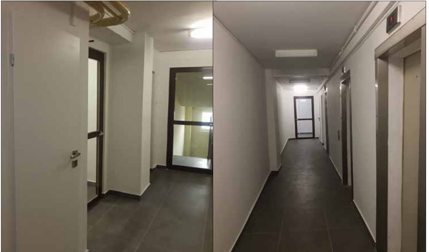
Haperowiec – wyremontowane korytarze
