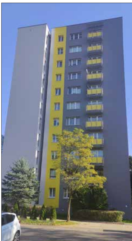
Termomodernizacja budynku przy ul. Mysłowickiej 1C
