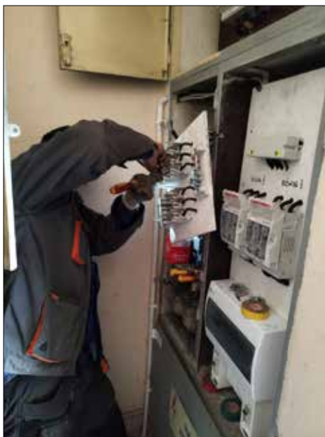
Konserwatorzy Administracji w akcji – modernizacja tablicy energetycznej przy ul. Mysłowickiej 16
