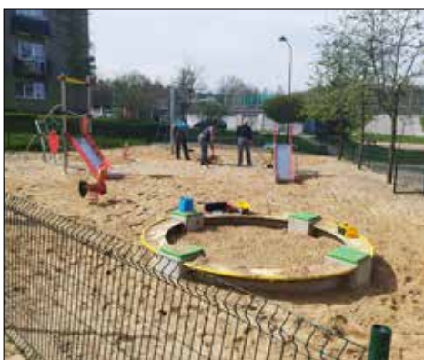
Uzupełnianie piasku na Placu Zabaw przy ul. Mysłowickiej 7 przez konserwatorów osiedla
