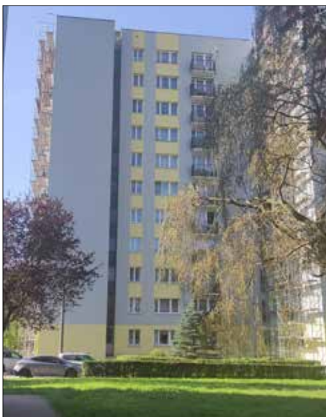
Budynek przy ul. Mysłowickiej 14 po remoncie elewacji
