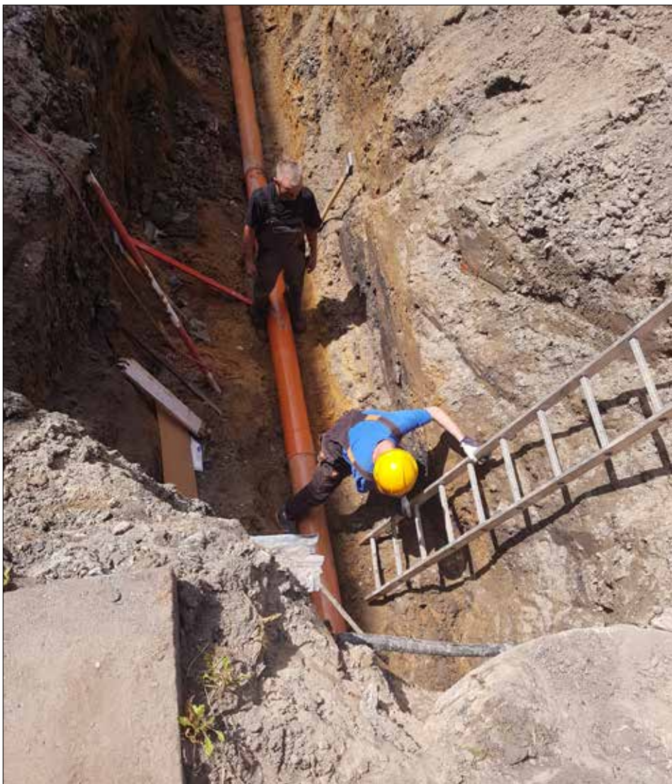
Remont sieci kanalizacyjnej w rejonie budynków przy ul. Mysłowickiej 1a-1b wykonywany przez pracowników administracji
