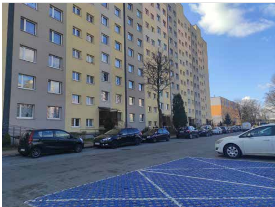
Nowo wyremontowany odcinek drogi wraz z parkingiem przy ul. Wojciecha 47-47d
