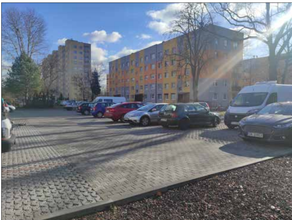
Wyremontowany parking przy ul. Wojciecha 27-27b
