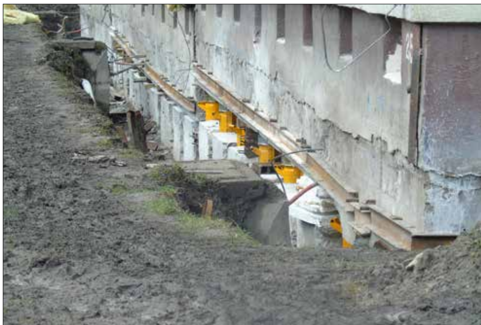
Osiedle Giszowiec – rektyfikacja (pionowanie) budynku przy ul. Wojciecha 31-31b
