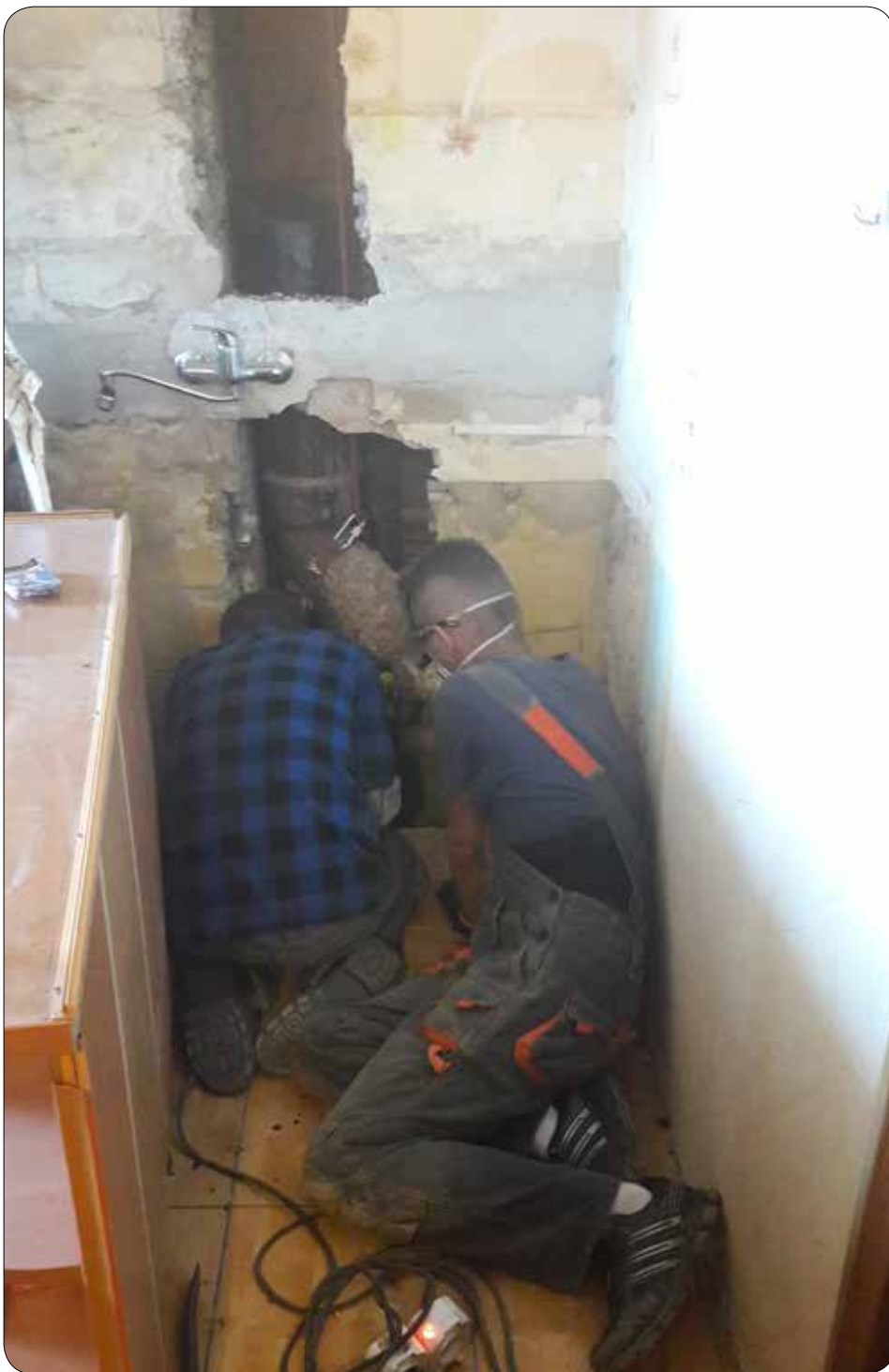
Osiedle Giszowiec – konserwatorzy Administracji Osiedla przy pracach remontowych
