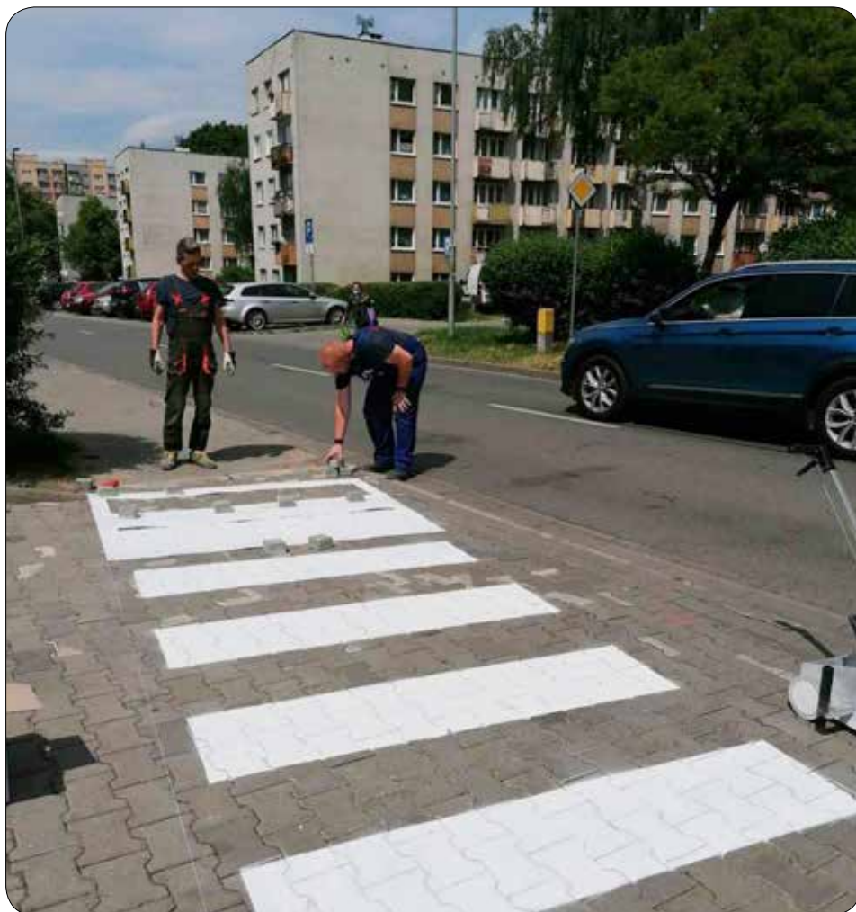
Osiedle Giszowiec – prace konserwacyjne
