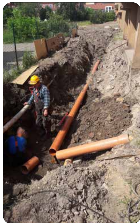
Konserwatorzy osiedla przy wymianie kanalizacji sanitarnej
