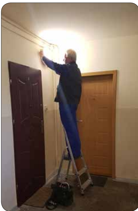
Wymiana opraw oświetlenia przez konserwatora
