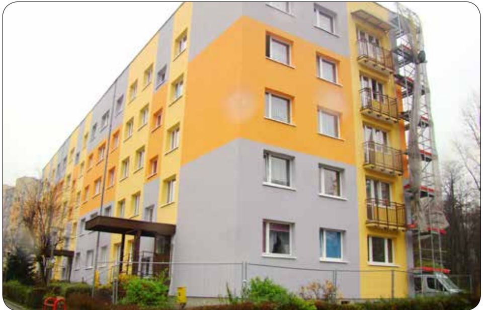
Trwają prace termomodernizacyjne
